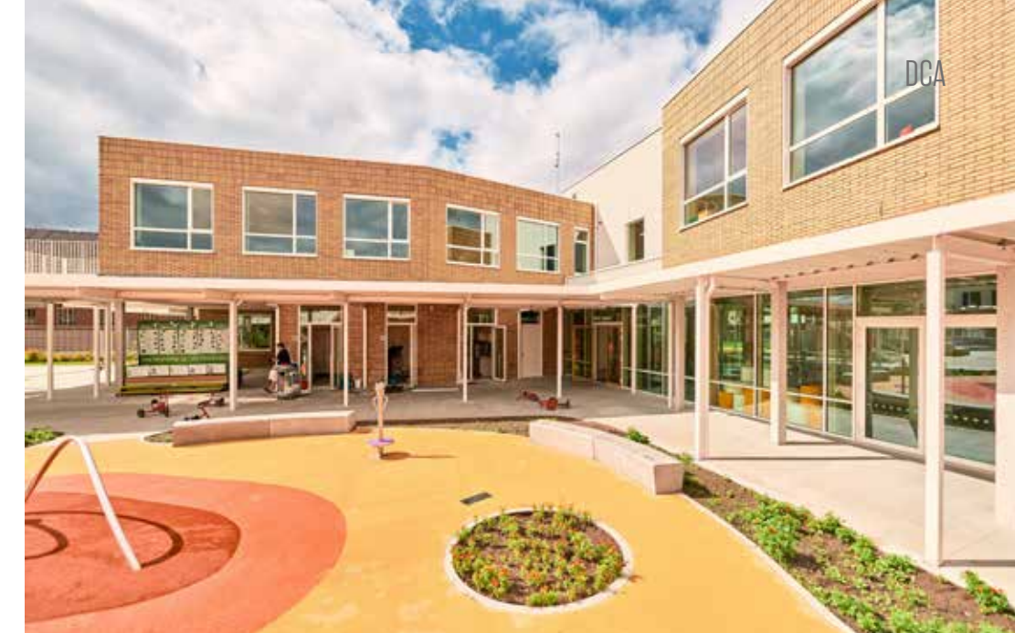
Het schoolgebouw telt twee bouwlagen en is goed voor zo'n 4.500 m 2 vloeroppervlakte.
