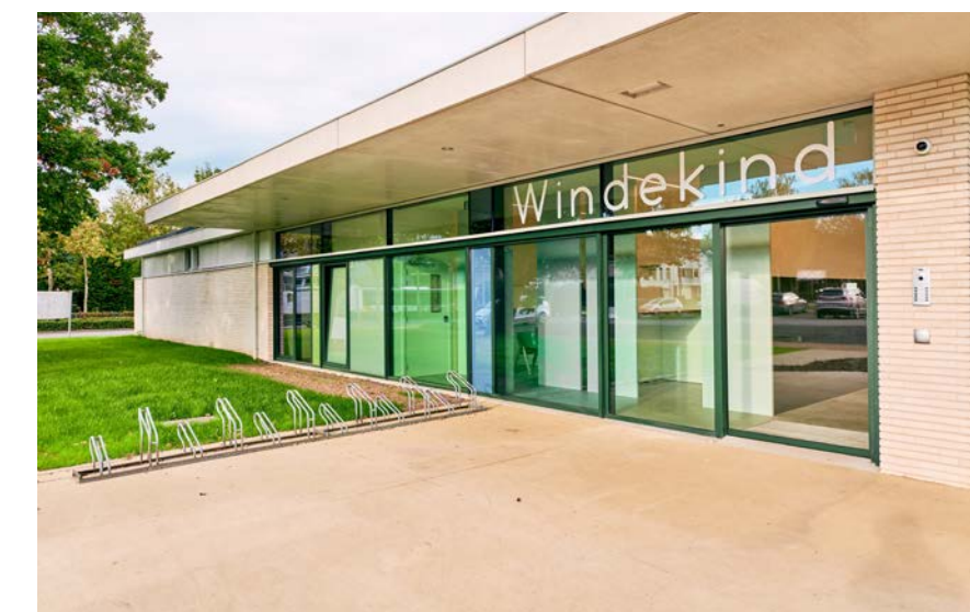
Het kinderdagverblijf telt (voorlopig) één bouwlaag van 1300 m 2 die in een betonstructuur werd opgetrokken.
